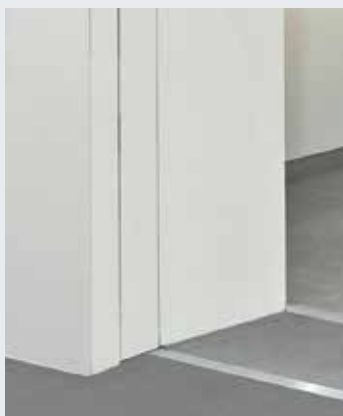
Kłapa do niszy przy otwartej bramie
